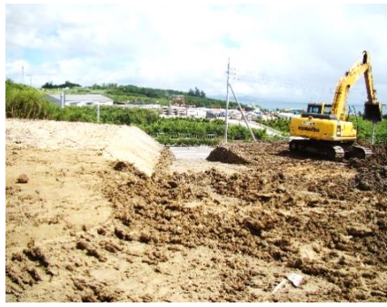
②原野を農地への造成工事
